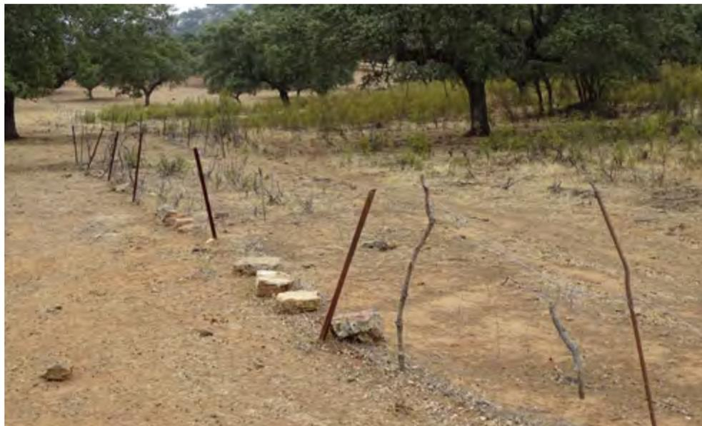
Figura 22.2.2. Vallado de tipo ganadero en mal estado de conservación y poco funcional
