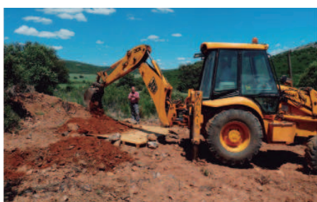
Construcción de majano de pallets
